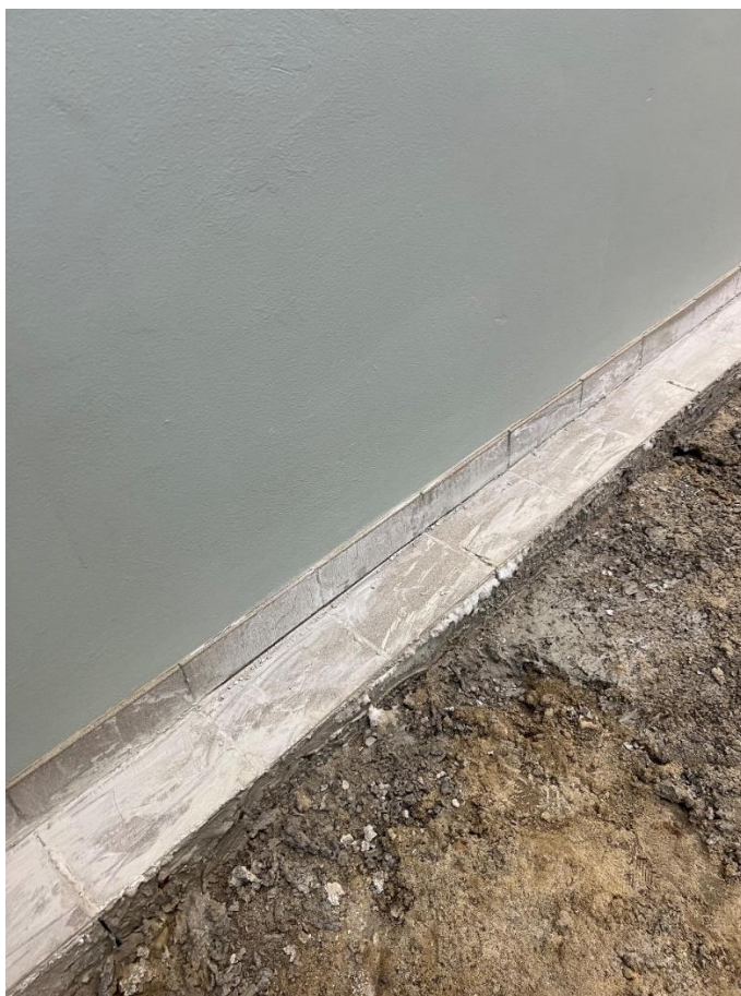
Bilde 3, Viser gulfstripe som står igjen under lecavegge etter at gulvet er revet opp og fjernet
